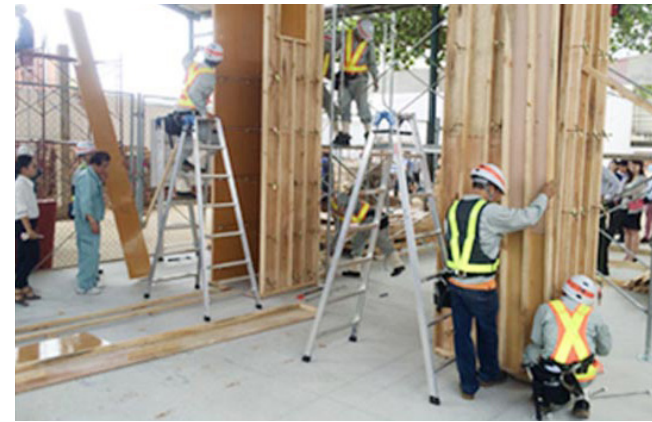
型枠建込みの実習のようす
